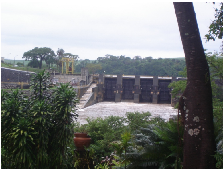
Represa no Rio Mogi Guaçu, com gerador es em operação parcial.
